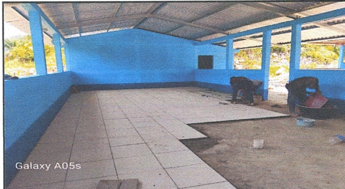
FOTOGRAFIA 3: Instalacion de pisos ceramicos en el modulo de aulas, se observa la aplicacion de la pintura en muros interiores y la cubierta de lamina.
