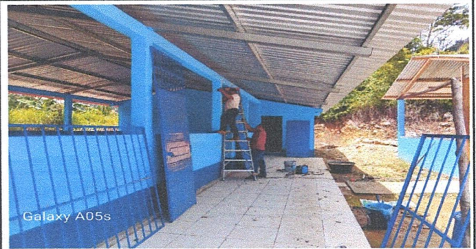
FOTOGRAFIA 2: Se observa la instalacion de las puertas y ventanas.
