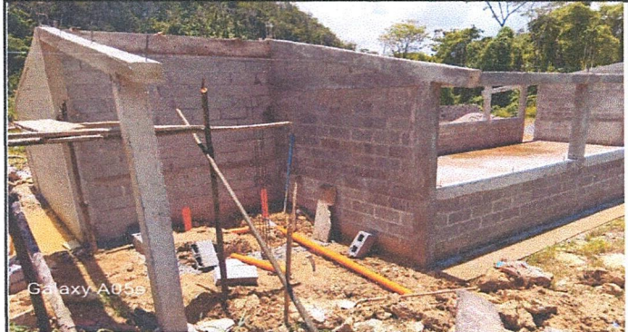
FOTOGRAFIA 6: Vista de la instalacion de tuberia de drenaje y entortado de concreto de los baños.
