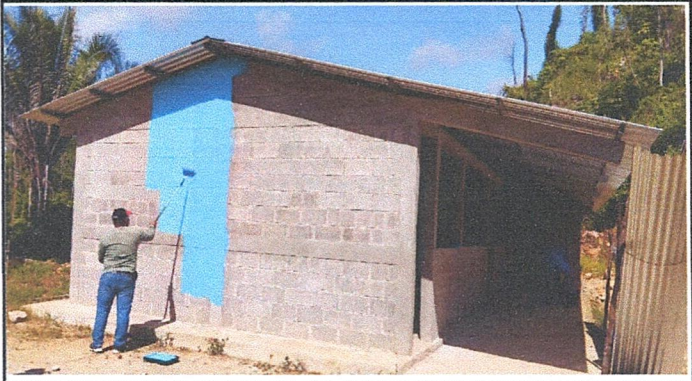
FOTOGRAFIA 4: Vista de la pintura de pared exterior.
